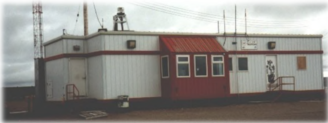
Aéroport de Taloyoak
